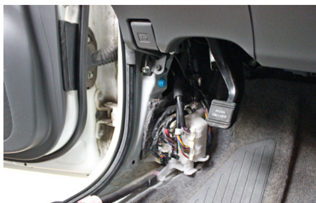
Фото 1.4. Накладка левой кик-панели снята
